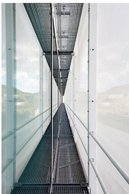
**Lösung:** Die transluzente Fassade aus PTFE Glas als offenporiges Gittergewebe spannt über ein umliegendes, eigens für die Anforderungen der Architektur entwickeltes Rahmensystem. Zugunsten des homogenen Erscheinungsbildes wurde der Fugenverlauf zwischen den Elementen auf ein Minimum reduziert, bei einer Rahmentiefe von max. 140mm. Ein gefedertes nachspannbares System hält die Membranspannung auch bei sich ändernden Wetterbedingungen auf einem gleichbleibenden Niveau.
