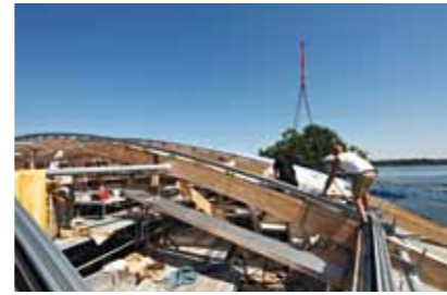
Verbessert wurde auch die Verbindung zwischen Holz und pneumatischer Konstruktion. Kondensat kann jetzt optimal abgeleitet werden. | The connection between wood and pneumatic design was improved, too. Water condensation can now run off in an optimum way.
