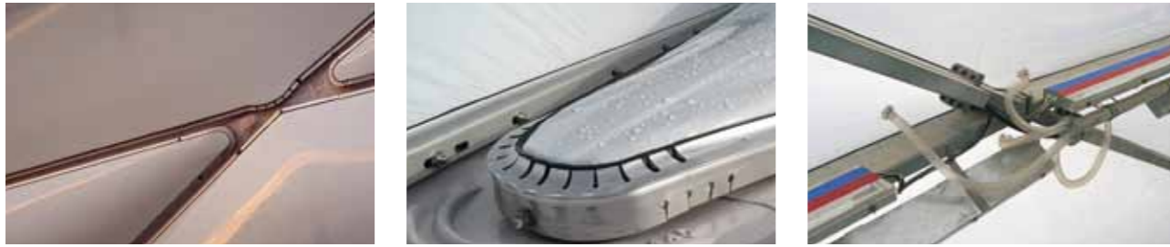
Gerundete Klemmverbindungen. Sie wurden extra für die Allianz Arena entwickelt | Curved clamp connections. Specially developed for the Allianz Arena.
