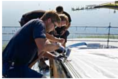
Verbessert wurde auch die Verbindung zwischen Holz und pneumatischer Konstruktion. Kondensat kann jetzt optimal abgeleitet werden. | The connection between wood and pneumatic design was improved, too. Water condensation can now run off in an optimum way.
