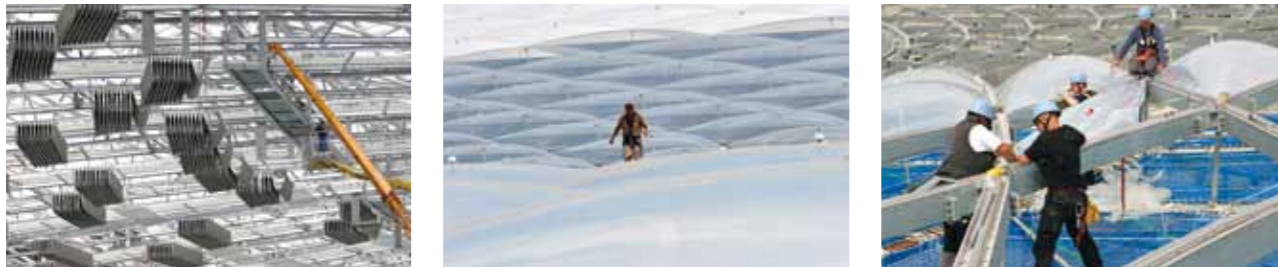
Speziell ausgebildete Seilkletterer inspizieren und warten die Arena einmal jährlich | Specially trained rope climbers provide annual inspection and maintenance for the Arena.
