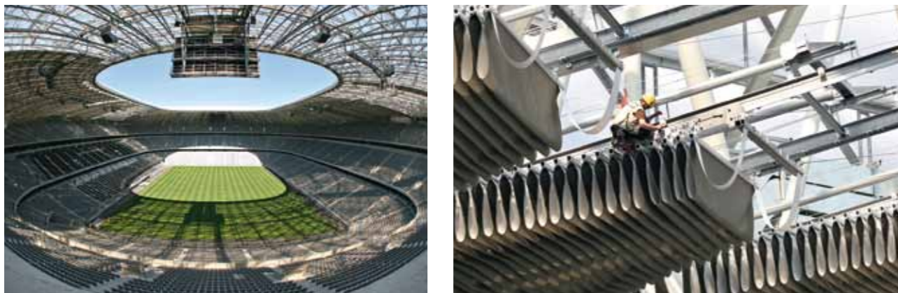
Auch wenn die Gebläseanlage einer Station defekt ist, gilt es, sofort zu handeln. | If the fan system of one section is out of order, immediate action must be taken.
