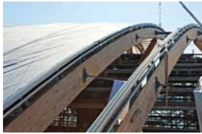
Verbessert wurde auch die Verbindung zwischen Holz und pneumatischer Konstruktion. Kondensat kann jetzt optimal abgeleitet werden. | The connection between wood and pneumatic design was improved, too. Water condensation can now run off in an optimum way.
