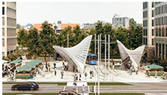
Schwabinger Tor Trambahn, München 280 m 2 ETFE-Kissen Dach/roof + Stahl/steel Bild von / Image by Fischer & Kurzlechner Architekten
